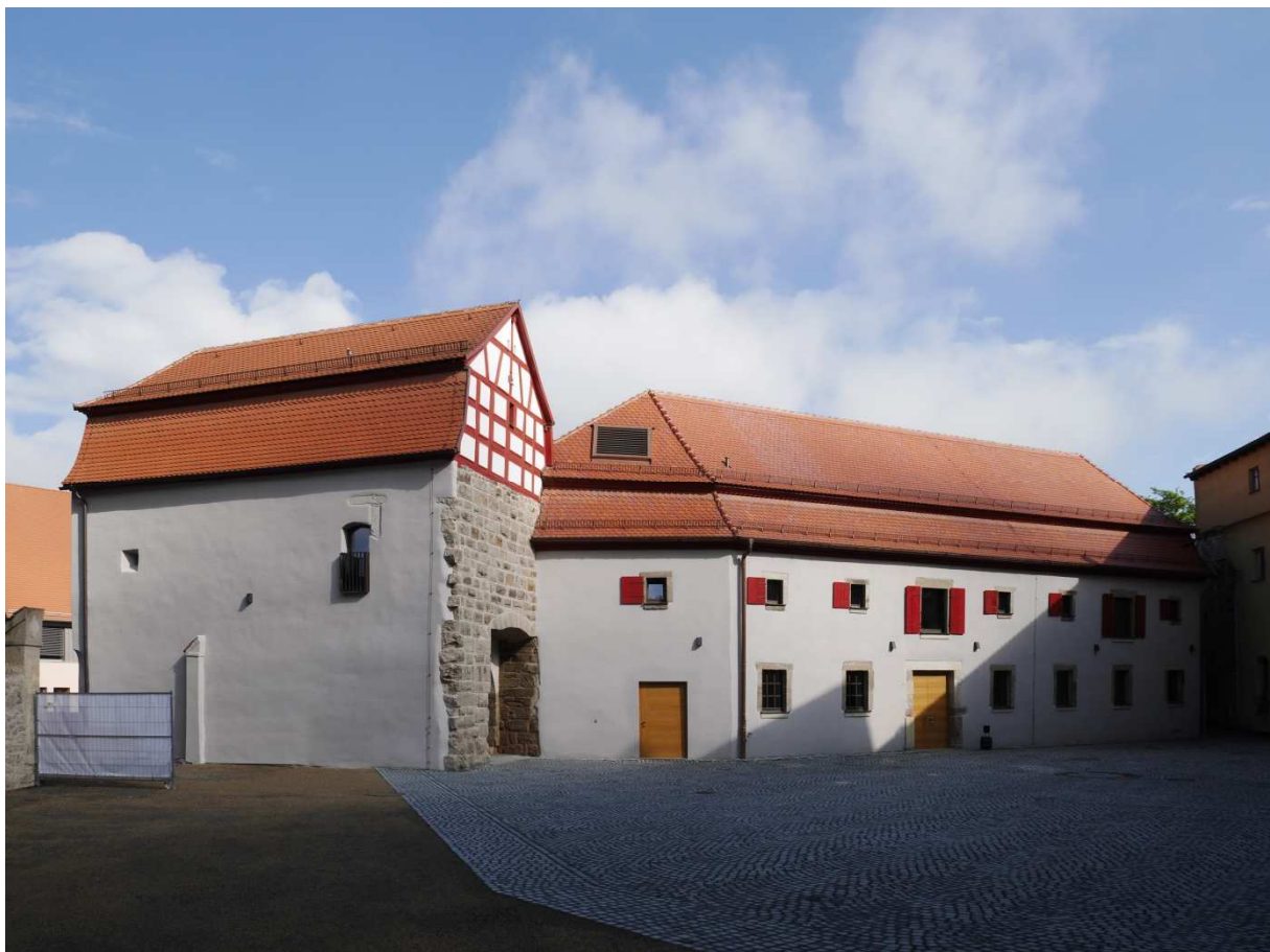
Abbildung 2: Torhaus und Bauteil E nach der Sanierung – Blick vom Schlosshof
