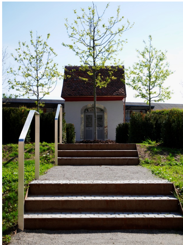
Abbildung 8: Bauteil K „Gartenhäuschen“ nach der Sanierung
