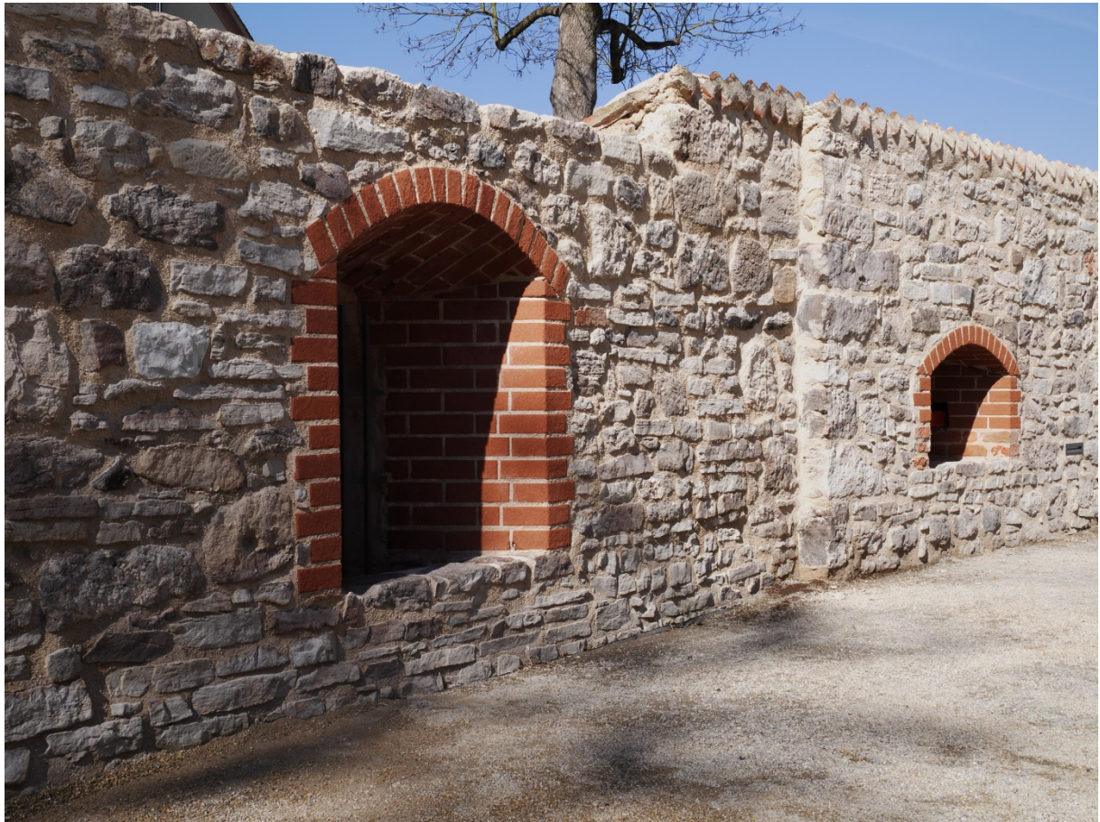
Abbildung 7: Denkmalgerecht sanierte Schießscharten im Schlosshof
