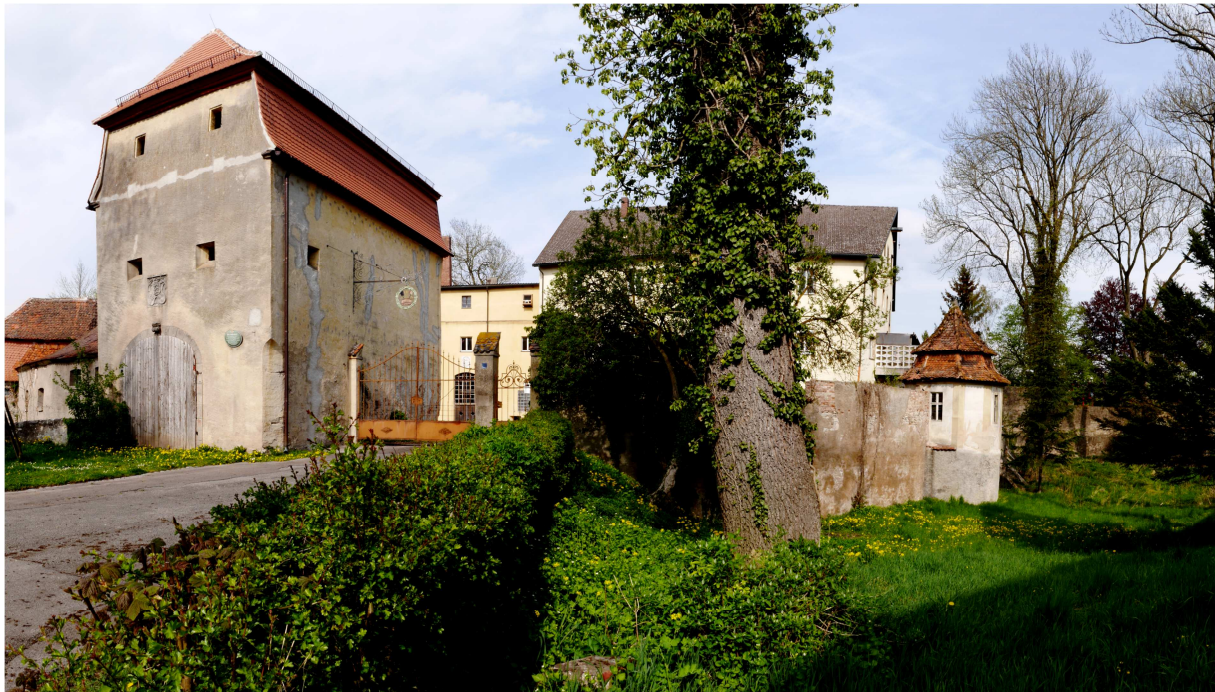
Abbildung 1: Stadtschloss Herrieden vor der Sanierung – Ansicht von Südwesten
