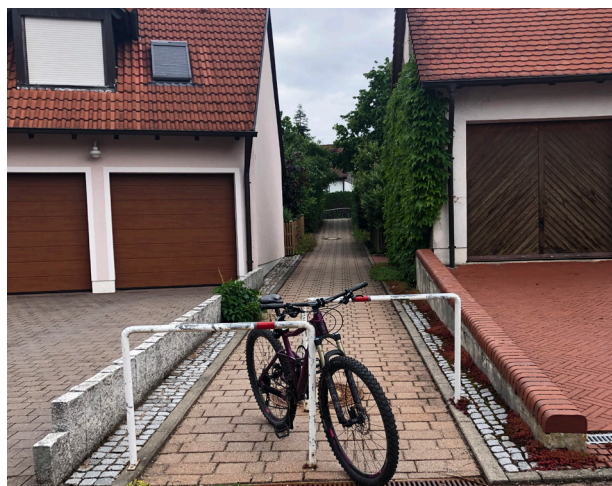
Abbildung 22: Umlaufsperrn fahrradfreundlich gestalten am Beispiel des Wegs zwischen Königsberger Straße und Lehrberger Straße
