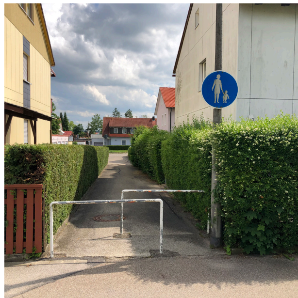
Abbildung 19: Beispiel Schwächen: fehlende Freigabe des Fußwegs für den Radverkehr und nicht richtlinienkonforme Umlaufsperrn (Bayernring)
