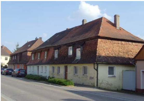
Häuserzeile Neunstetter Straße 11 -17 (Foto Arch.büro)
